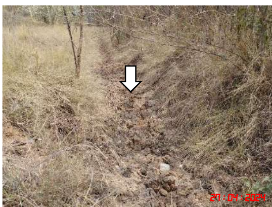
รูปที่ 14 คุระบายน้ำรอบพื้นที่การทำเหมือง
